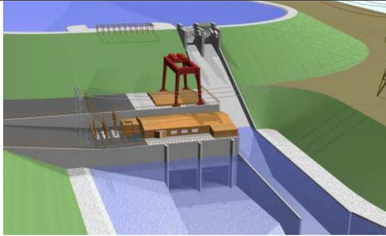
Приведите компоновочную схему изображённого гидроузла с регулируемым поверхностным открытым водосбросом и приплотинным зданием ГЭС, а так же продольный разрез по водосбросному сооружению.
